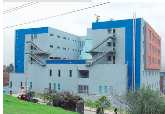
Torre II del Hospital USS MEISSEN de Bogotá (2018-2019)
